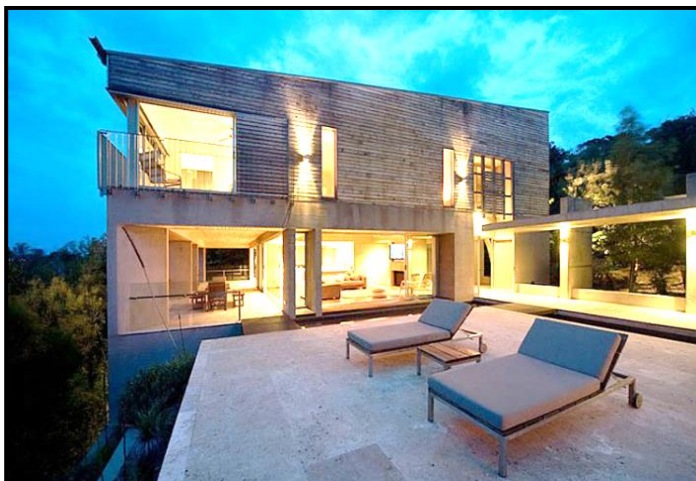
FIGUUR 8c: Grose Bradley (LGI Architects), Alingi Residence (Alingi-woonhuis) , beton, glas en houtlatte, Australië, 2005.
