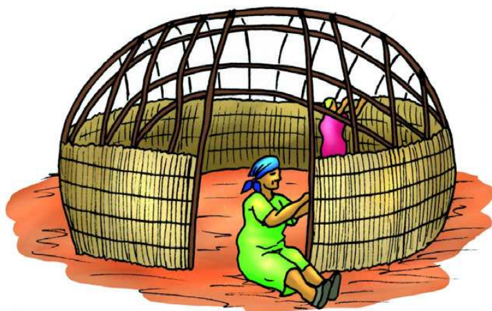
Vroue wat die rietmatte aan die raamwerk vasmaak.
