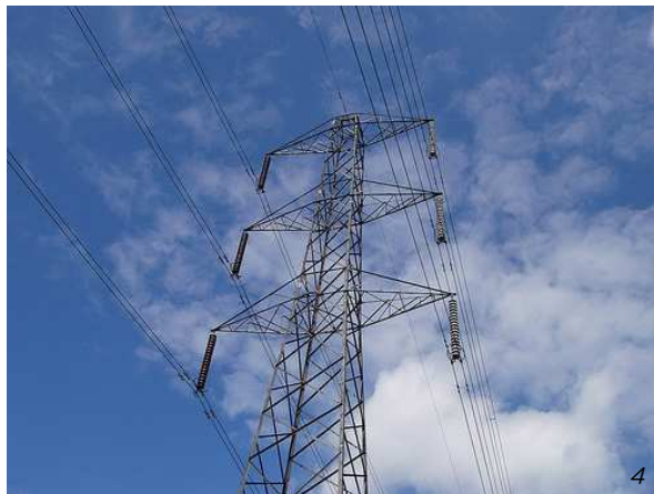
'n Spantoring ("pylon" in Engels) is 'n raamstruktuur wat elektriese hoogspanningsdrade ondersteun.
