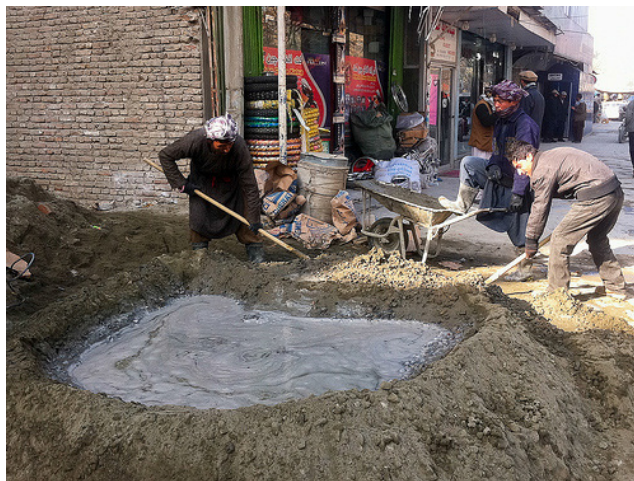
Bouers meng sement deur grawe te gebruik.
